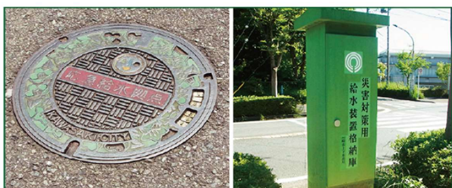
応急給水拠点・給水栓 応急給水拠点・給水装置格納庫
