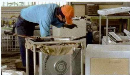
家電製品の解体作業
